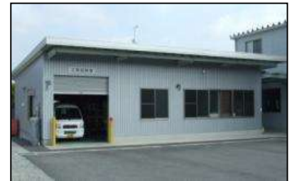
本社 土質試験室棟
