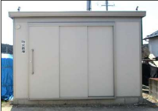
◆ 防災倉庫設置
