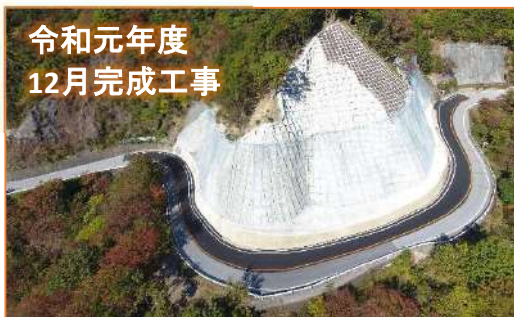
国道306号 補助道路修繕工事(工区3)
