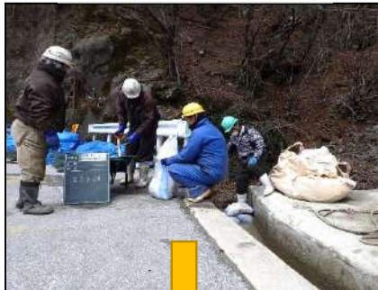
土のう作製・土のう積
