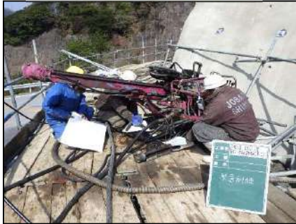
オイルマットの使用状況
