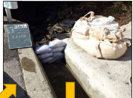
土のう積・吸着マット
