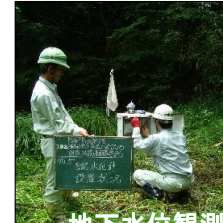
地下水位観測
