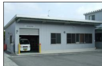
本社 土質試験室棟
