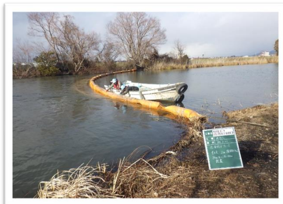
汚濁防止フェンス設置
