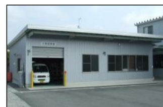
本社 土質試験室棟
