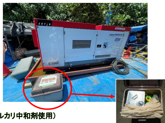
油漏れ対策(防油堤・油漏れ緊急処理BOX設置)
