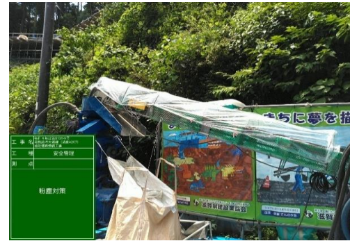
粉塵対策(養生シートの設置)
