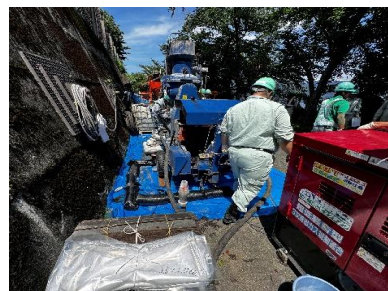
(土のう設置完了)
