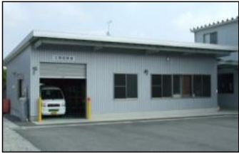
本社 土質試験室棟
